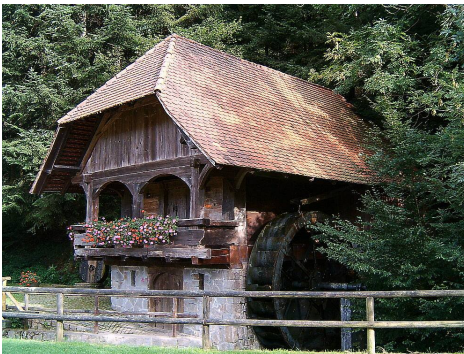
M1: Mühle u. Speicher Haslach / Hofstetten
